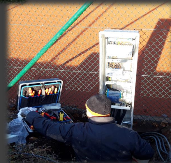
Projekt Platzsanierung und Elektroarbeiten 2020/21
