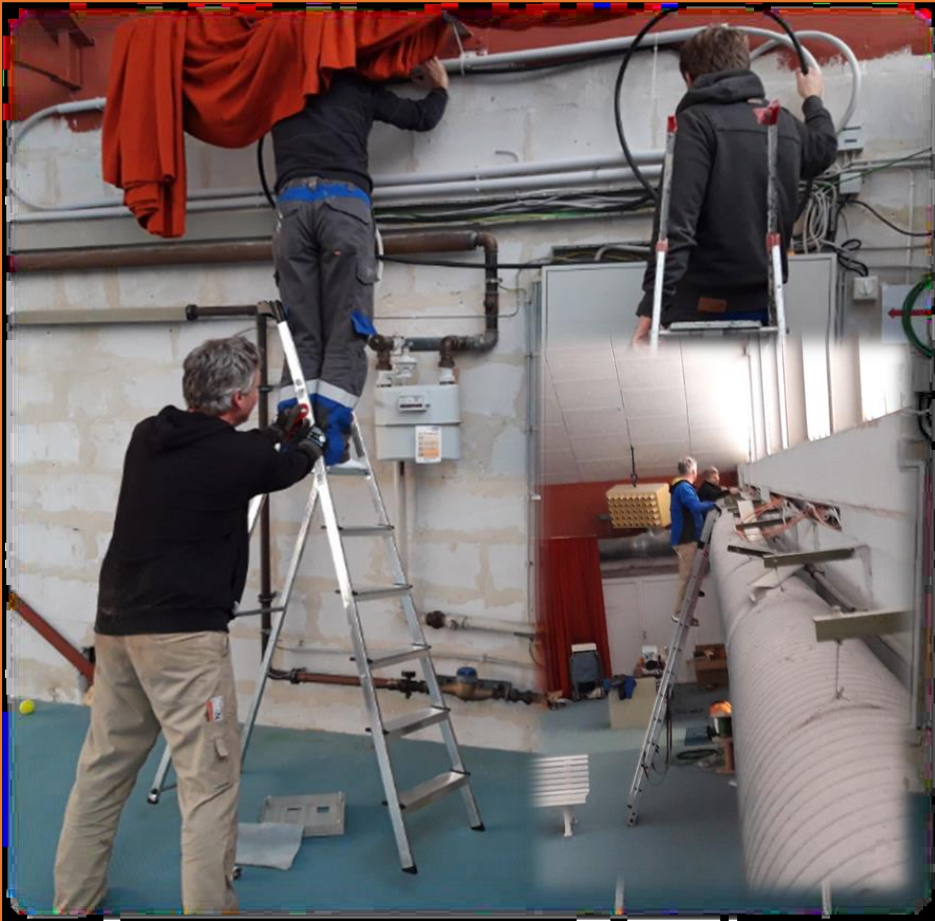
Projekt Platzsanierung und Elektroarbeiten 2020/21
